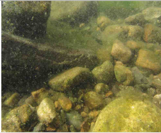
P8하행 교각 보호사석, 상태 양호
