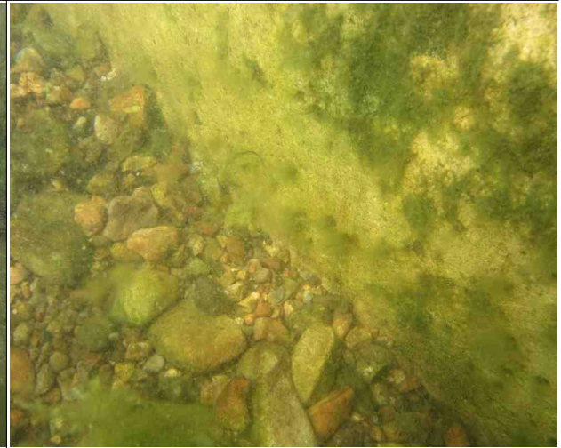
P8상행 교각 기초저면, 상태 양호
