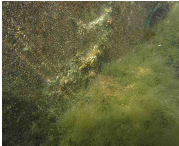
P8상행 교각 기초저면, 상태 양호
