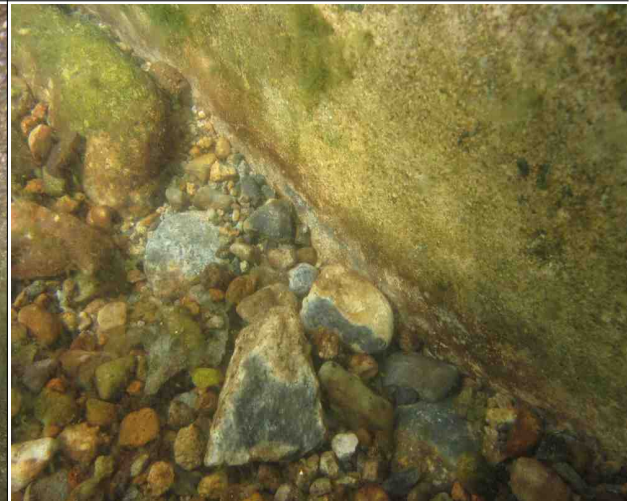
P8상행 교각 기초저면, 상태 양호
