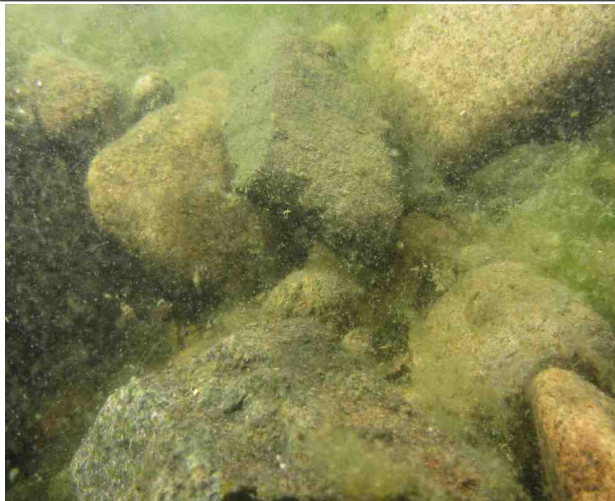
P8하행 교각 보호사석, 상태 양호
