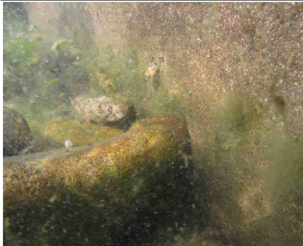
P8상행 교각 기초저면, 상태 양호
