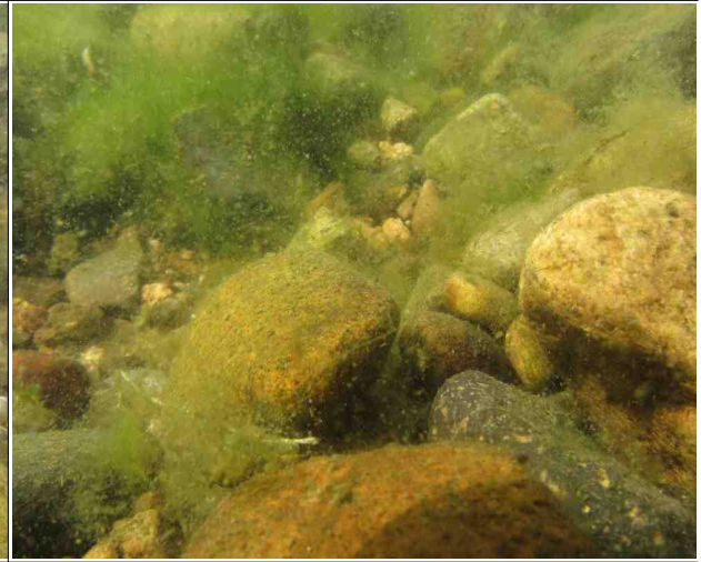
P8하행 교각 보호사석, 상태 양호
