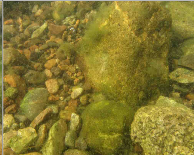
P8하행 교각 보호사석, 상태 양호
